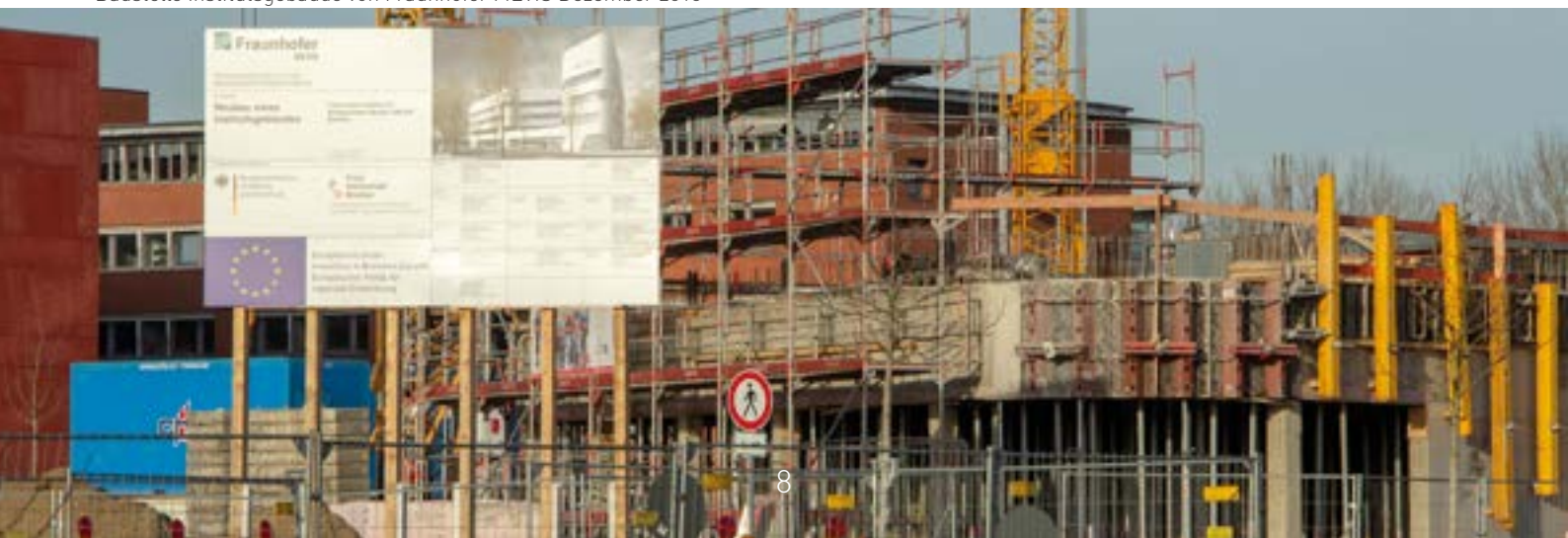
Baustelle Institutsgebäude von Fraunhofer MEVIS Dezember 2018
