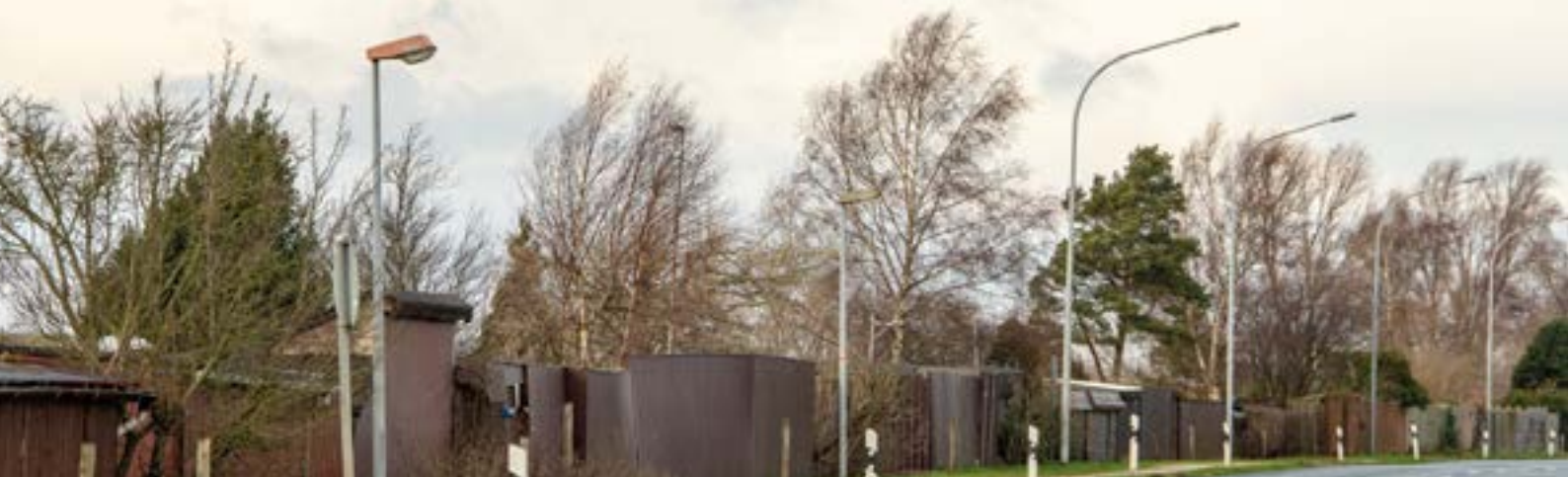
Im Vordergrund zwei alte Quecksilberdampfleuchte, dahinter die frisch installierten LED-Leuchten.
